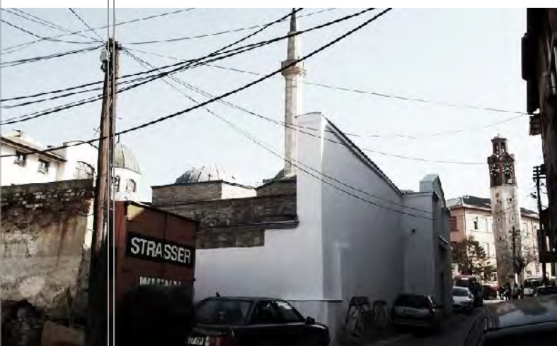
Humbja e elementeve burimore, aplikimi i materialeve bashkëkohore e në masë të madhe betonimi i strukturave të këtij monumenti, ka dërguar deri në tjetërsimin enorm të asaj që dikur njihet si Hamami i Madh i Prishtinës
