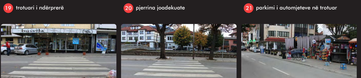
19 trotuari i ndërprerë 20 pjerrina joadekuate 21 parkimi i automjeteve në trotuar
